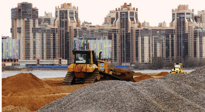
Прокуратура Петербурга ищет новые квартиры с чистовой отделкой по цене «голых стен». ФОТО: BALTRPHOTO
